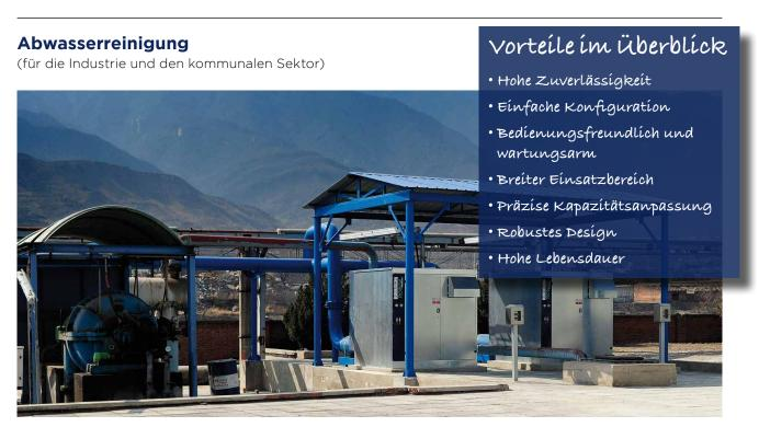
Die moderne Abwasserbehandlung erfordert das Handling großer Luftmengen bei niedrigem Druck. Die PD-Gebläse von Robuschi stehen als Garant für die verschiedenen Prozesse dieser Anwendung zur Verfügung.
